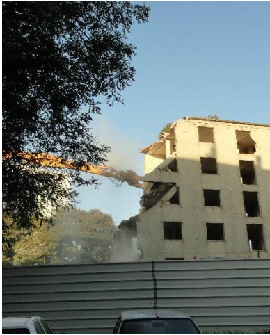
Démolition des bâtiments Brel « les toits plats » en 2013
