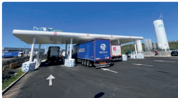
22 décembre - Mise en service de la station multi-énergies de Sigeif Mobilités à Réau
